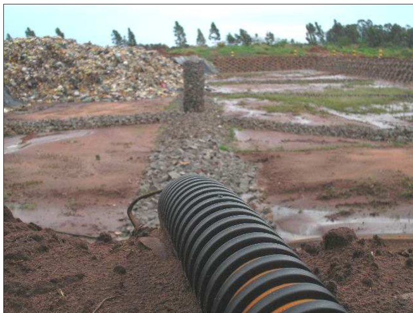
Figura 19: Paisagem mostrando parte do sistema de drenagem de líquidos percolados - Fonte: Albertin, R.M., 2008
