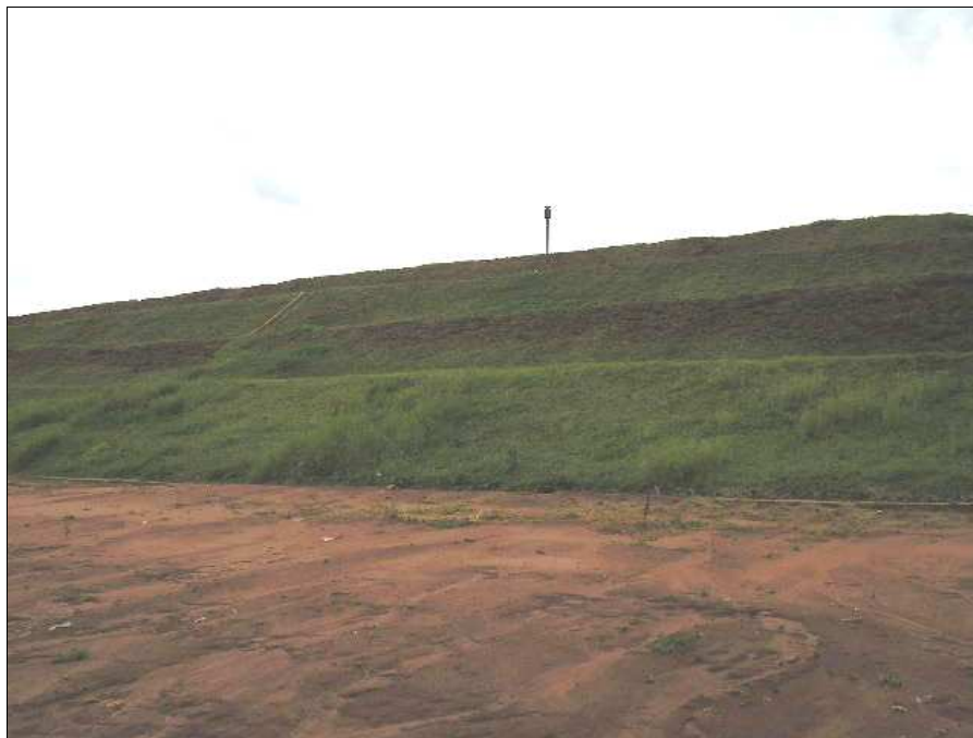
Figura 24: Vista parcial do aterro sanitário e chaminé de topo Fonte: Albertin, R.M., 2008
