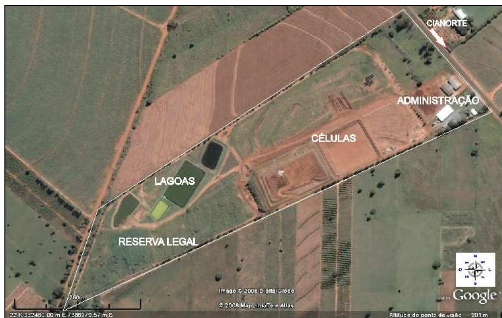
Figura 08: Vista aérea do aterro sanitário de Cianorte/PR Fonte: Google earth, 2008
