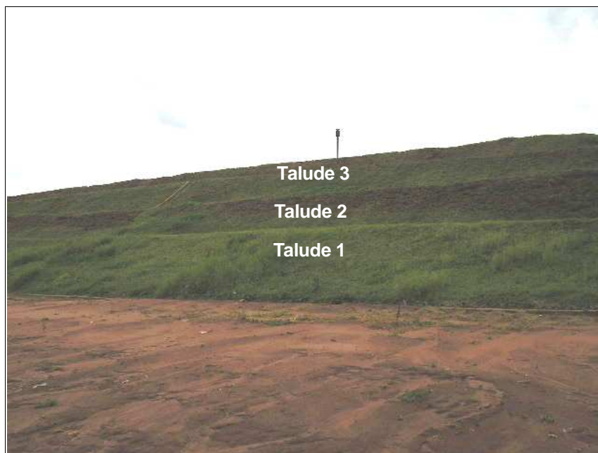
Figura 9: Vista parcial de célula concluída com três (3) taludes Fonte: Albertin, R.M., 2008
